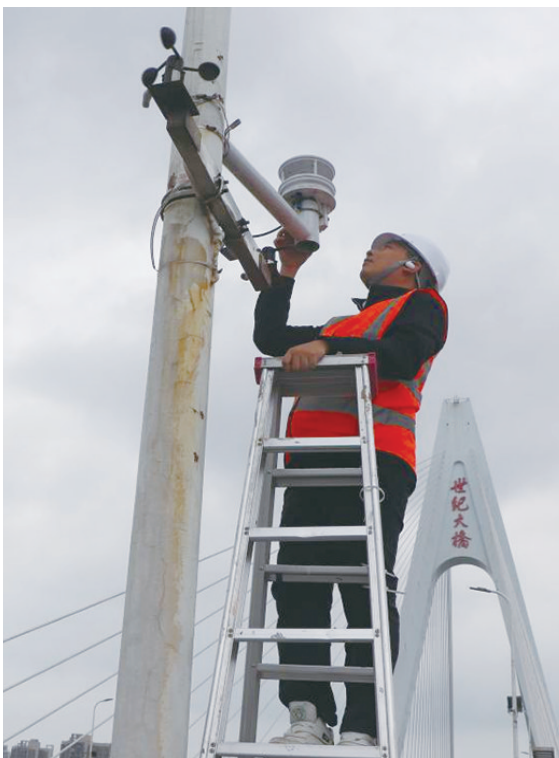
工作人员对世纪大桥智能监控系统进行巡检维护。 (海口市建工集团有限公司供图)
