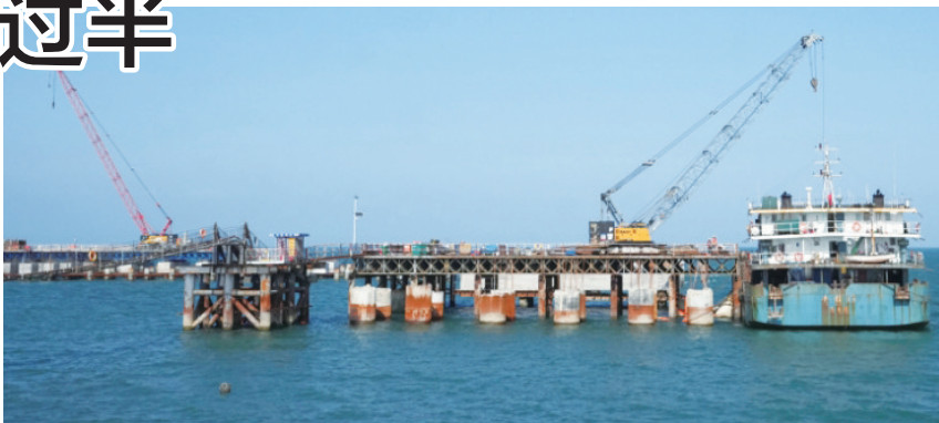
临高金牌港开发区港口正在施工。记者 王全印 摄
