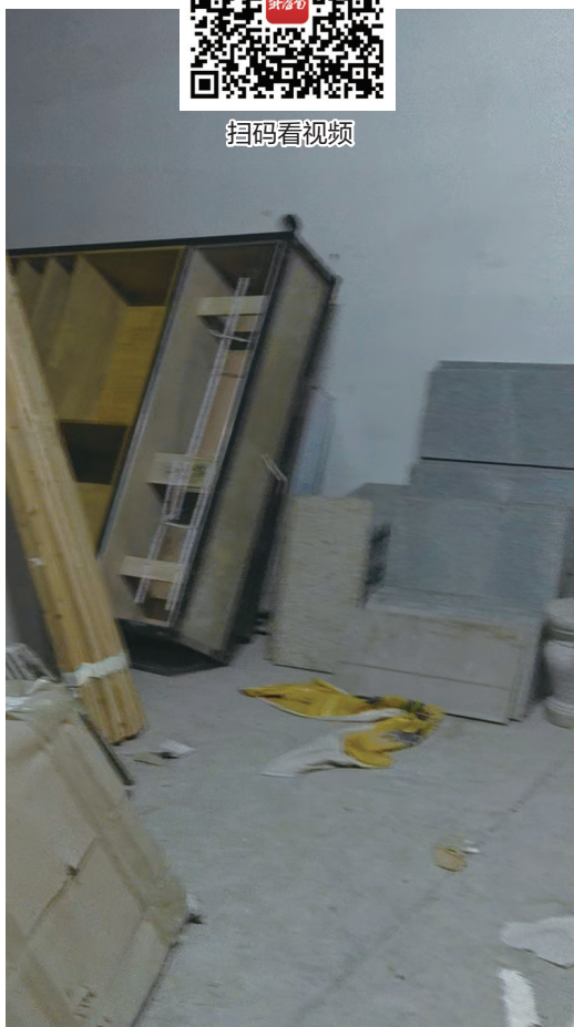
雅居乐金沙湾二期地库防火分区堆放大量杂物。
