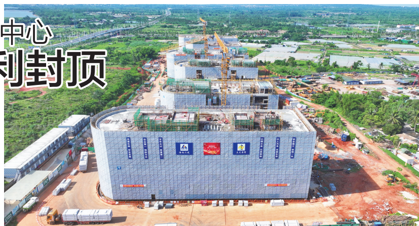
省残疾人康复中心项目5栋楼主体结构实现全面封顶。
