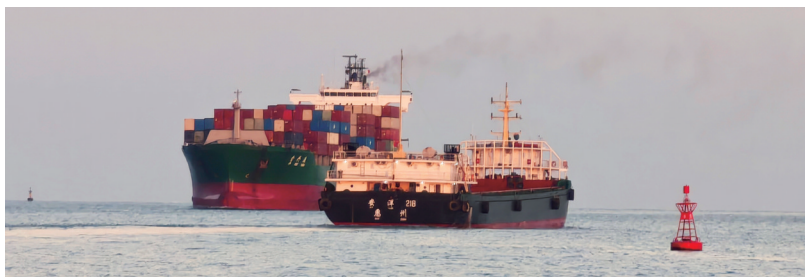
洋浦港航道外段实现3万吨级船舶双向通航。（洋浦海事局供图）
