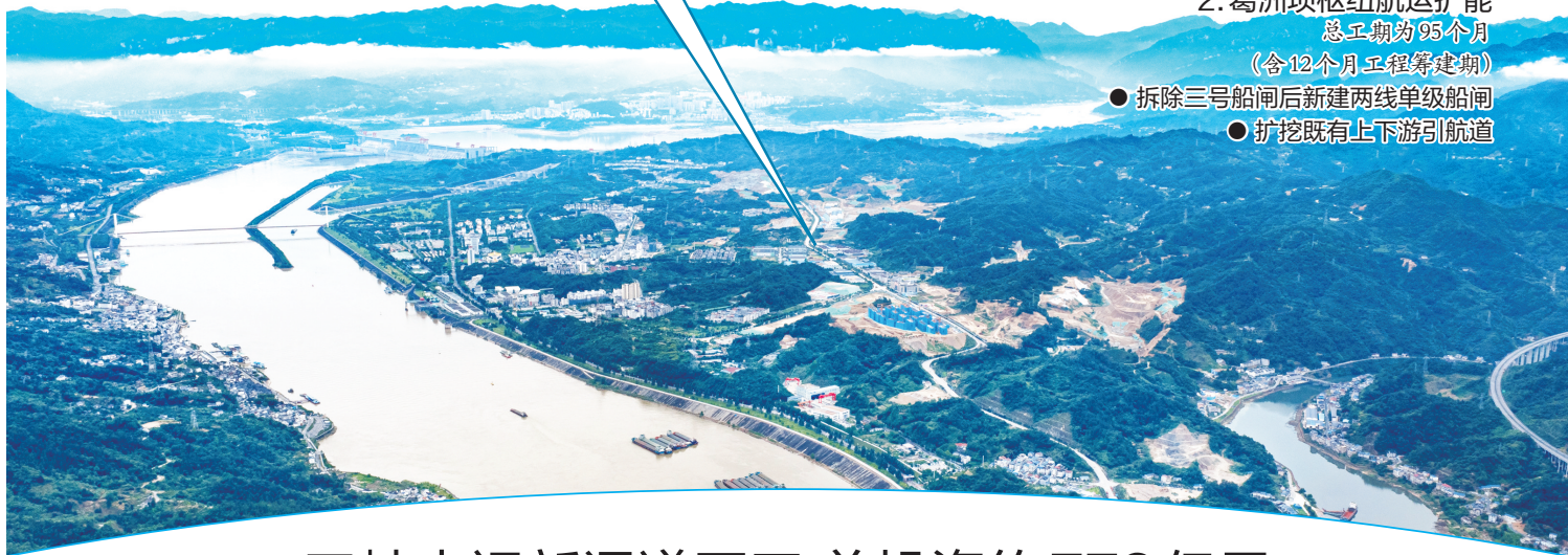
三峡枢纽新通道施工现场。(新华社记者肖艺九摄)
