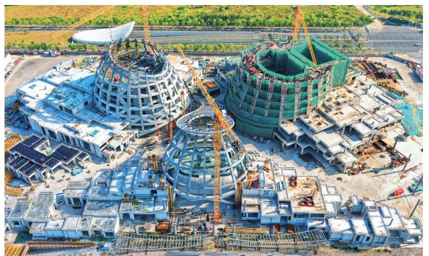
海南省艺术中心(演艺中心)项目施工现场。
