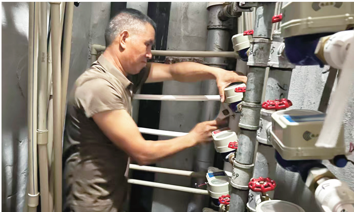
工人在恒大外滩更换水表。记者林文泉摄
