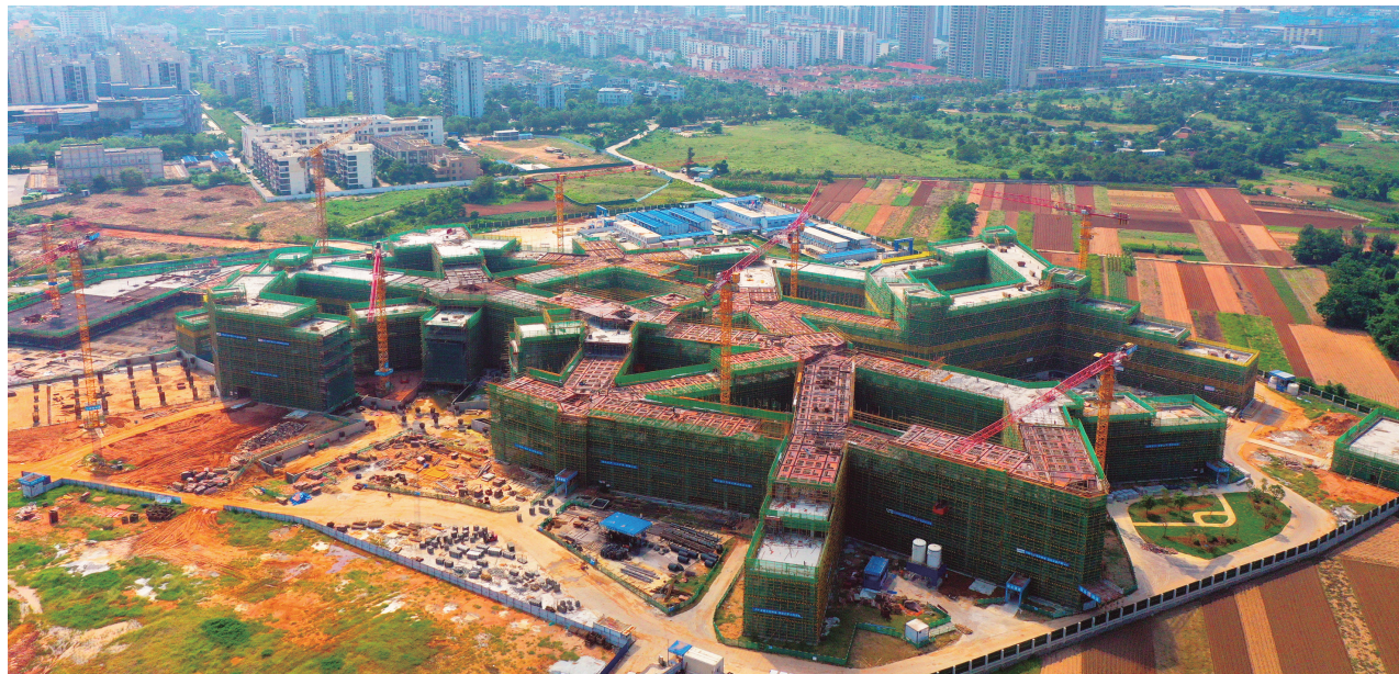
俯瞰海口长天中学项目建设现场,部分教学楼主体已封顶。
