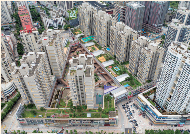
俯瞰海口友谊国贸城及居民楼。
