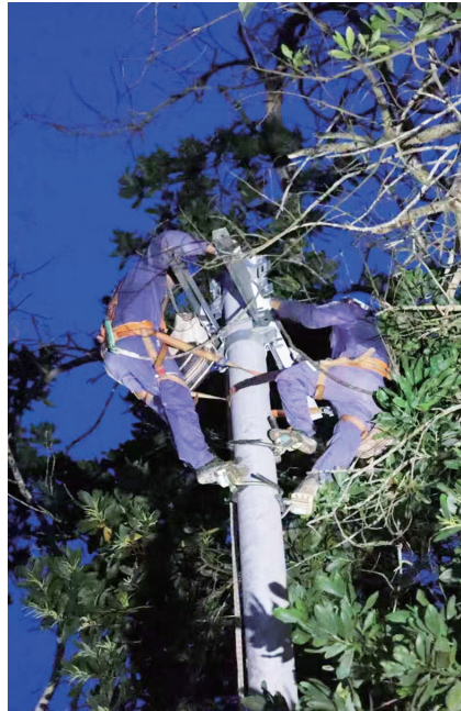
工作人员抢修10千伏大茶线受损线路。 (通讯员 闻策 摄)
