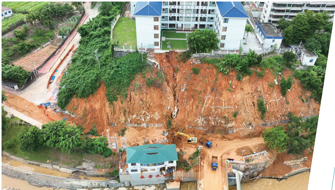
五指山中学边坡大面积崩塌后,挖掘机正在清理路面淤泥打通道路。记者 黄东光 摄
