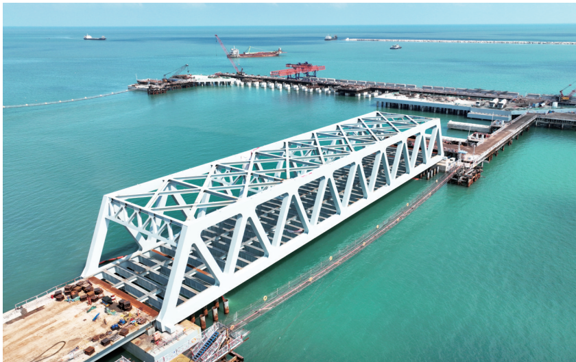
临高金牌港开发区港口及配套工程项目2号引桥钢桁梁顺利完成顶推及落梁施工。
