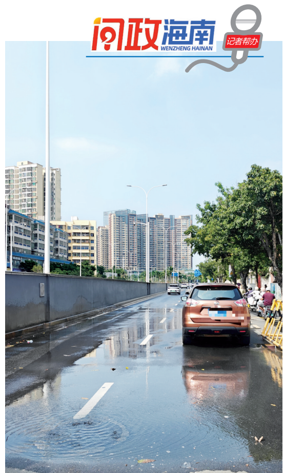
井盖污水外溢现象。
